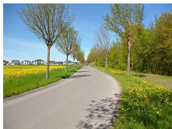
Abb. 11: Im Verfahren befestigter, gut erhaltener Feldweg (Bitumendecke). – Abb. 12: Zur Gemeindestraße ausgebauter Feldweg mit beidseitigen Alleebäumen.
