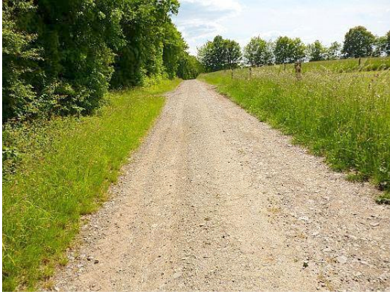
Abb. 3: Durch die Flurbereinigung befestigter (Schotterdecke) Feldweg in gut erhaltenem Zustand, mit seitlich angelegter Schutzpflanzung. - Abb. 4: Blick auf eine Hangstrecke mit angelegter Anpflanzung als Vogelschutzgehölz.
