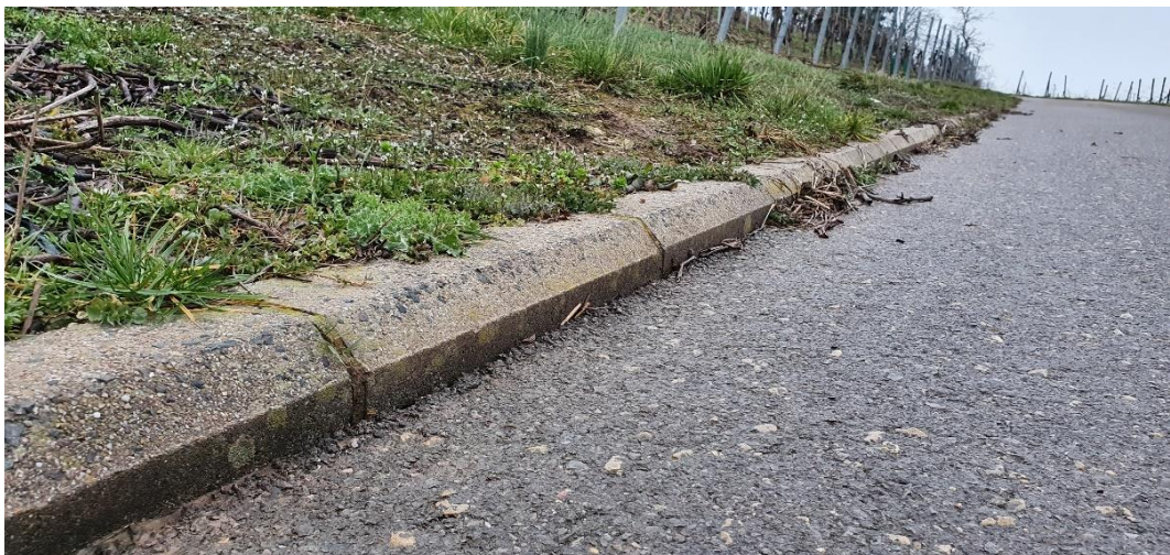
Abbildung 22: Bordsteine als Erosionsschutz in Schengen
