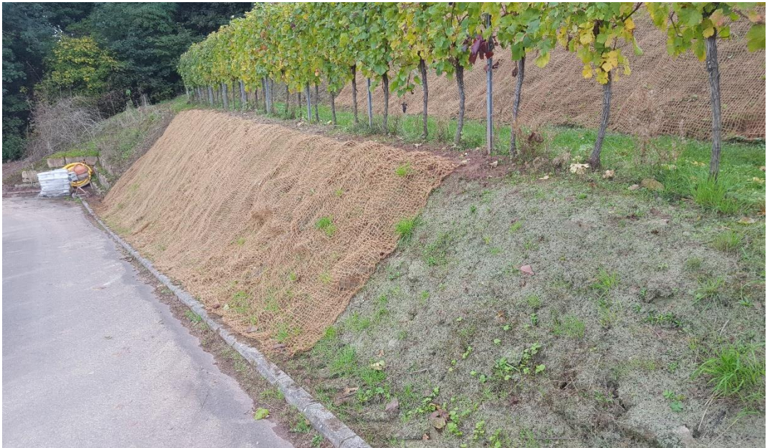
Abbildung 9: Nassansaat mit Matten aus Kokosgeflecht in Schengen
