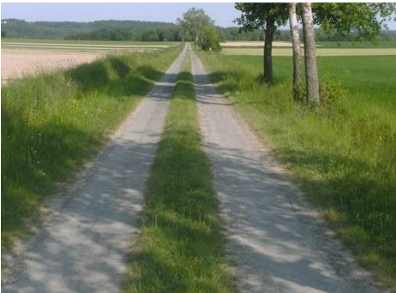
Abbildung 9: Spurweg mit Oberflächenbehandlung
