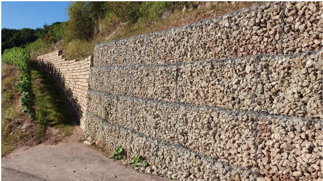
Abbildung 8: Hangstabilisierung durch Drahtschotterkörbe und Mauern in Schengen
